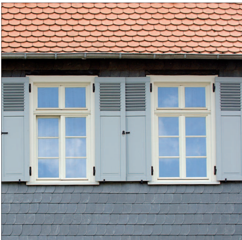
PaXretro mit Fensterbekleidung und Läden in einem barocken Herrenhaus von 1663.
